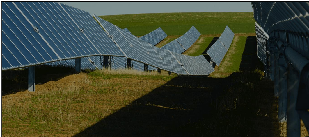
Figur 6 Solcelletrackere som følger terræn med spredt hældning.
